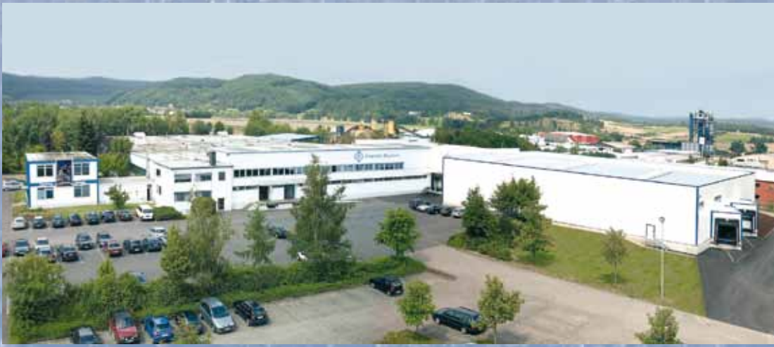
Franklin Electric Europa GmbH Wittlich, Germany
